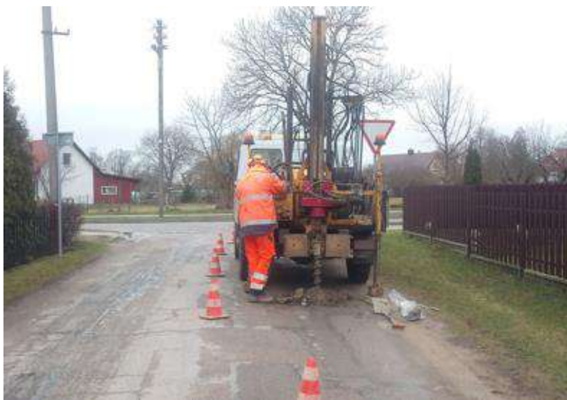
1 pav. Lauko darbai
